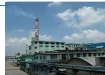
公司工厂锅炉
