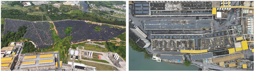
乳源基地光伏项目鸟瞰图
