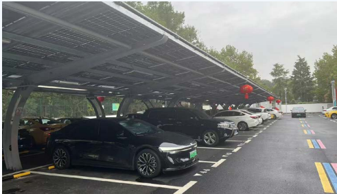
雨花东路场站光伏车棚 + 充电桩
