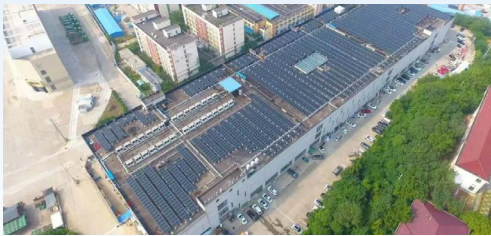
东扬家居光伏铺设
