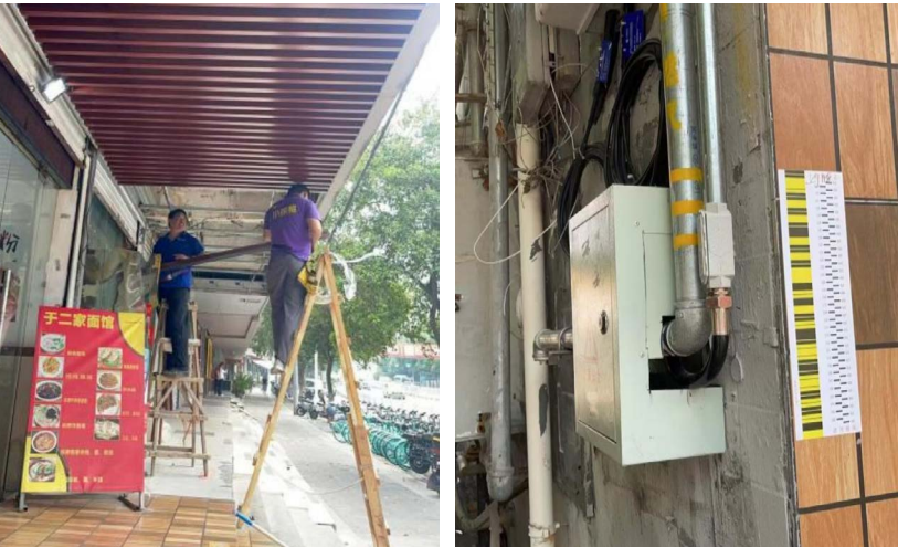
安心用气工程操作现场
