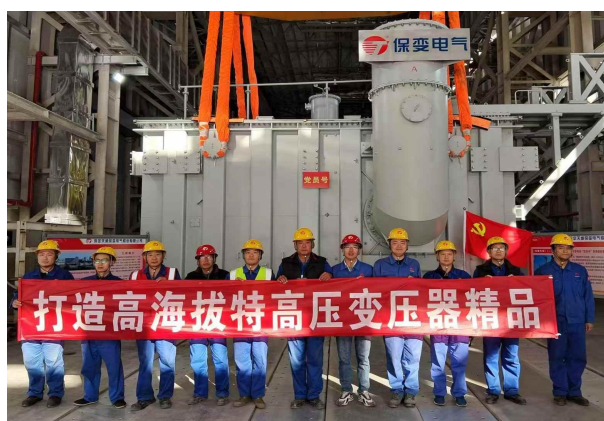
保变电气完成川渝特高压工程甘孜站 1000kV 现场组装“党员号”变压器
