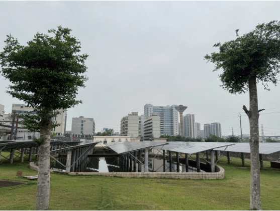
中水管网改造
