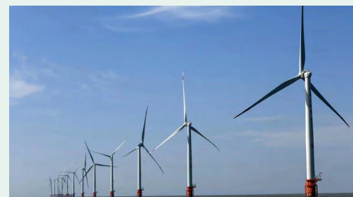
浙能嘉兴 1 号海上风电场项目
