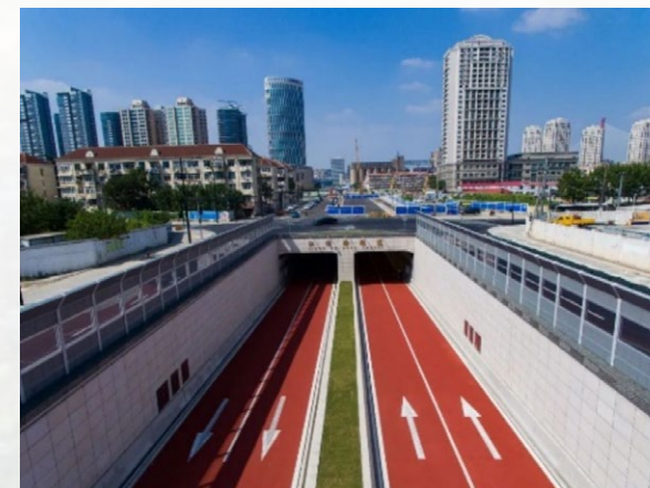
江浦路越江隧道新建工程
