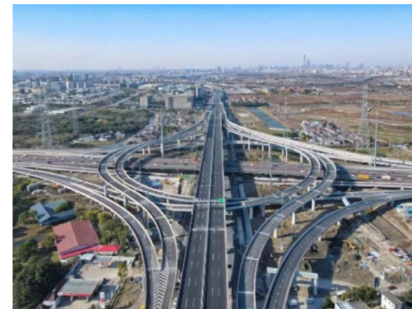
龙东大道（罗山路—G1501）改建工程
