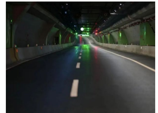
北横通道新建工程（西段）
