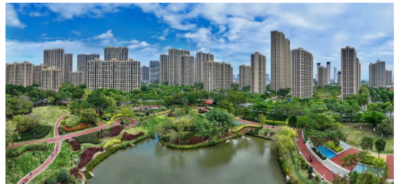
● 厦门洋唐居住区保障性安居工程项目
