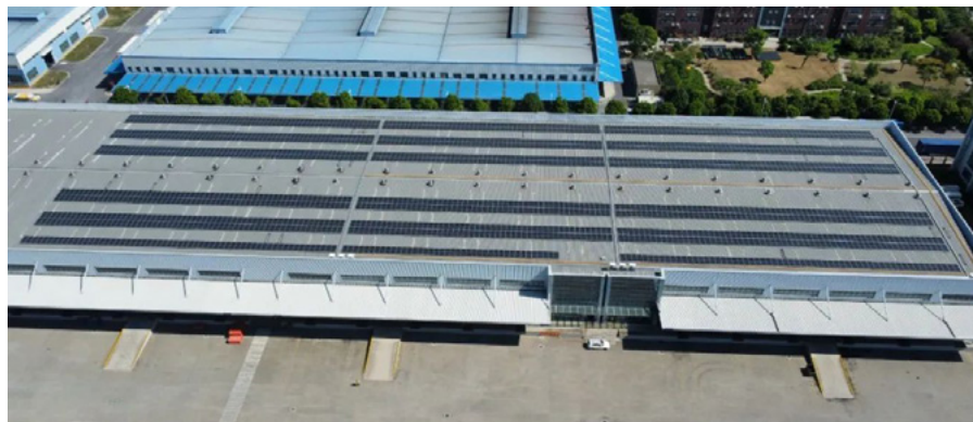
● 上海建发物流中心一期光伏电站
