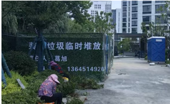
施工废料收集站封闭存放
