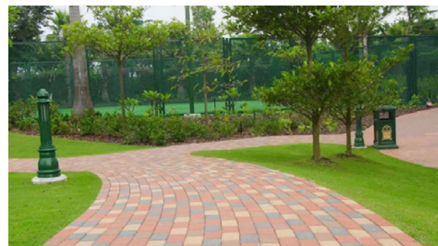
● 建发无锡玺云项目透水铺装
