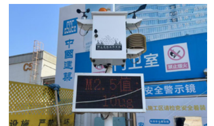
● 扬尘监控设备
