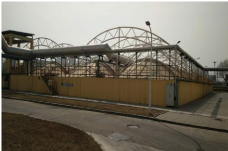
本埠污水处理厂 - 均质调节池
