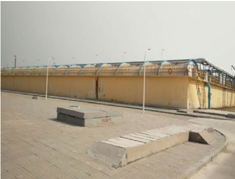
本埠污水处理厂一生化池
