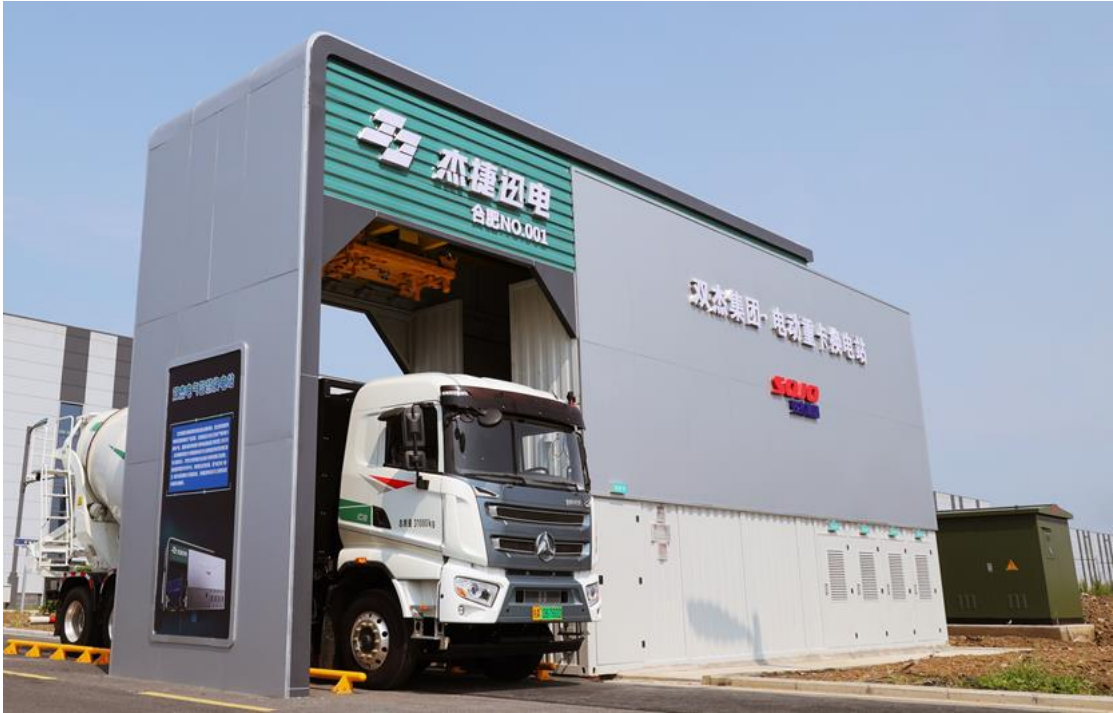
安徽合肥电动重卡换电站
