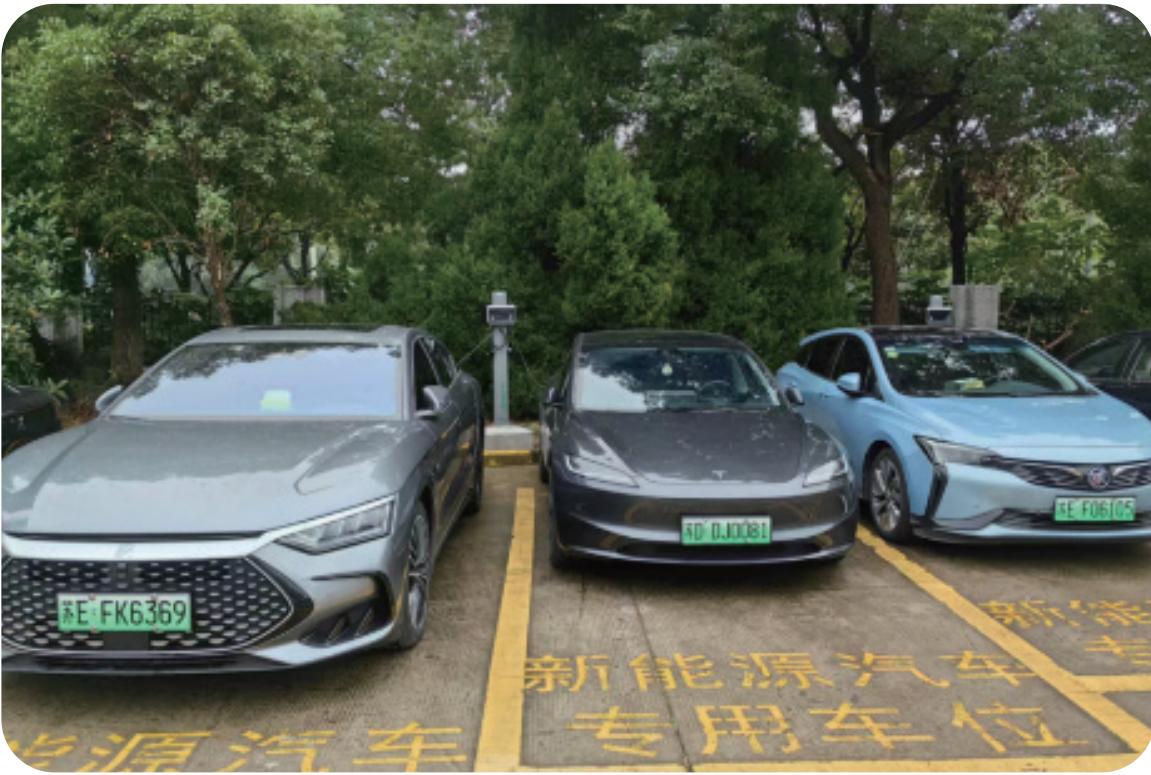
厂区充电桩建设图
