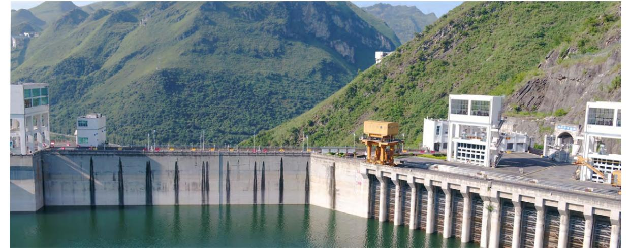
光照电站叠梁门分层取水进水口
