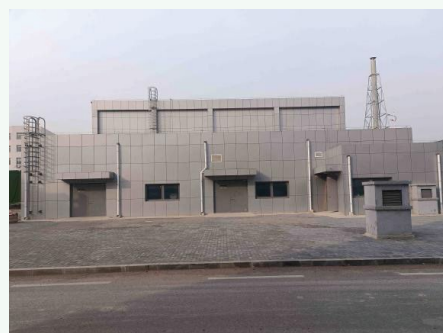
瓦房店基地新建污水处理站
