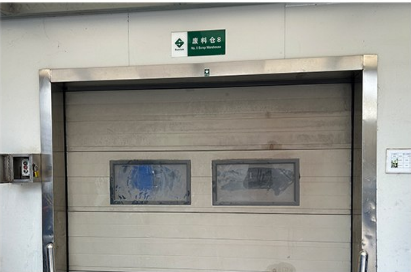
一般废料收集贮存设施
