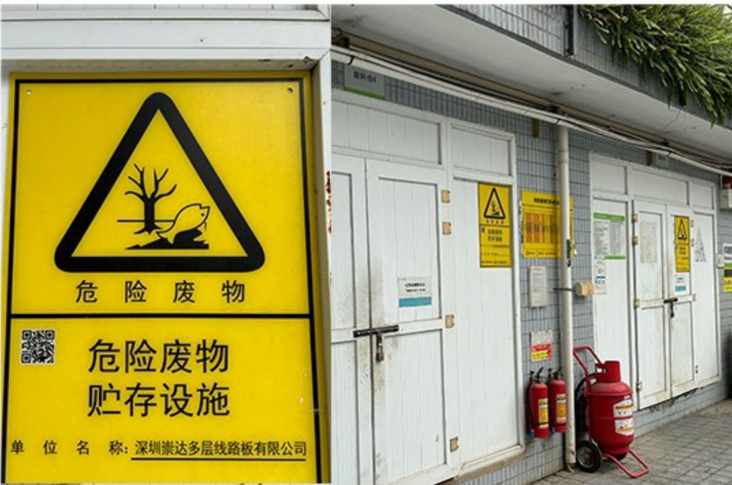
危险危废收集贮存设施
