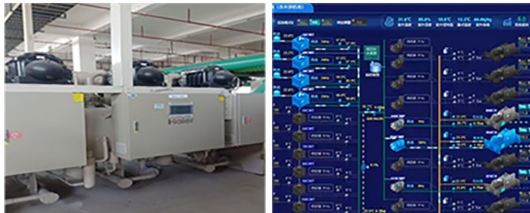
磁悬浮变频离心式冷水机组
