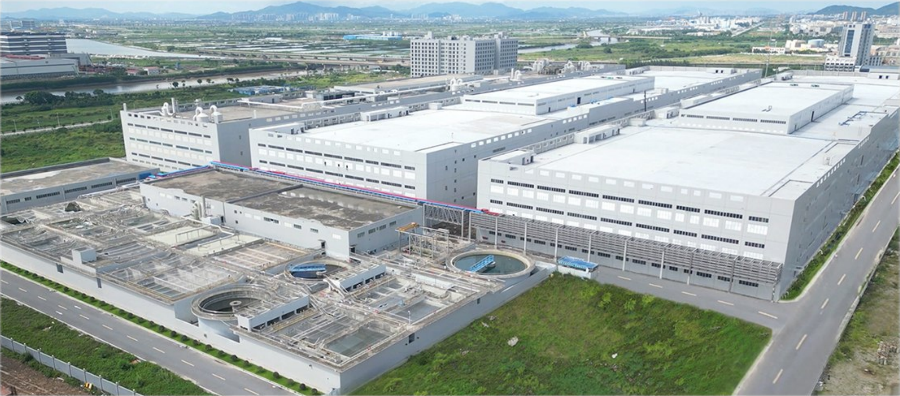
珠海厂废水站
