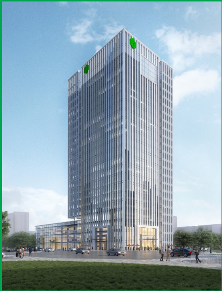
建设中的荆门总部研发大楼
