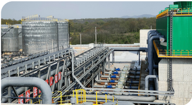
建设中的荆门无水氟化氢项目
