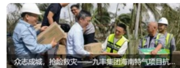
众志成城，抢险救灾——九丰集团海南特气项目抗... 九丰集团快速响应，采取诸多有效举措，既保障项目快速恢复，又确保员工安全，即将复工复产。
