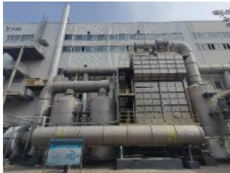
图注：新威远发酵车间废气治理设施
