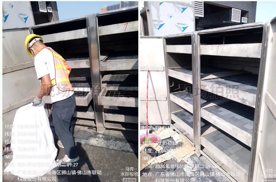
工作人员进行废气处理设备活性炭更换
