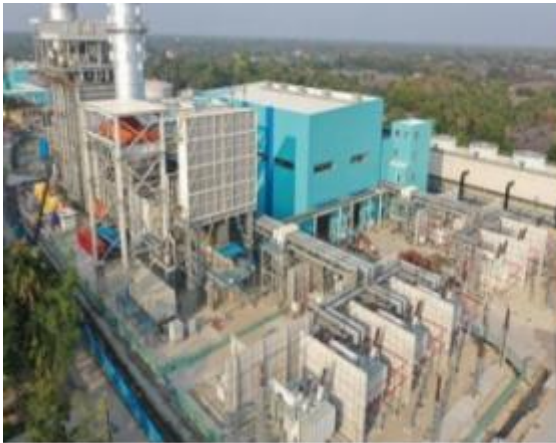
图 7：孟加拉 300MW 联合循环电站
