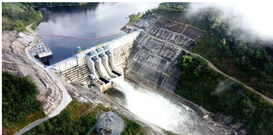
老挝南俄 4 水电站三台机组全部投入商业运行
