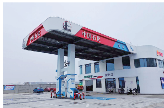
为“中国运河第一城”加氢，扬州首座综合能源站
