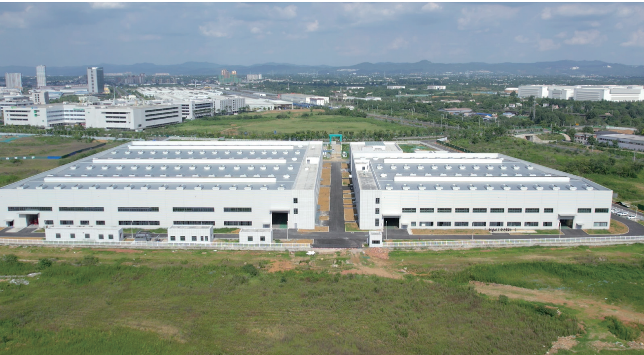
厚普股份在建氢能产业园
