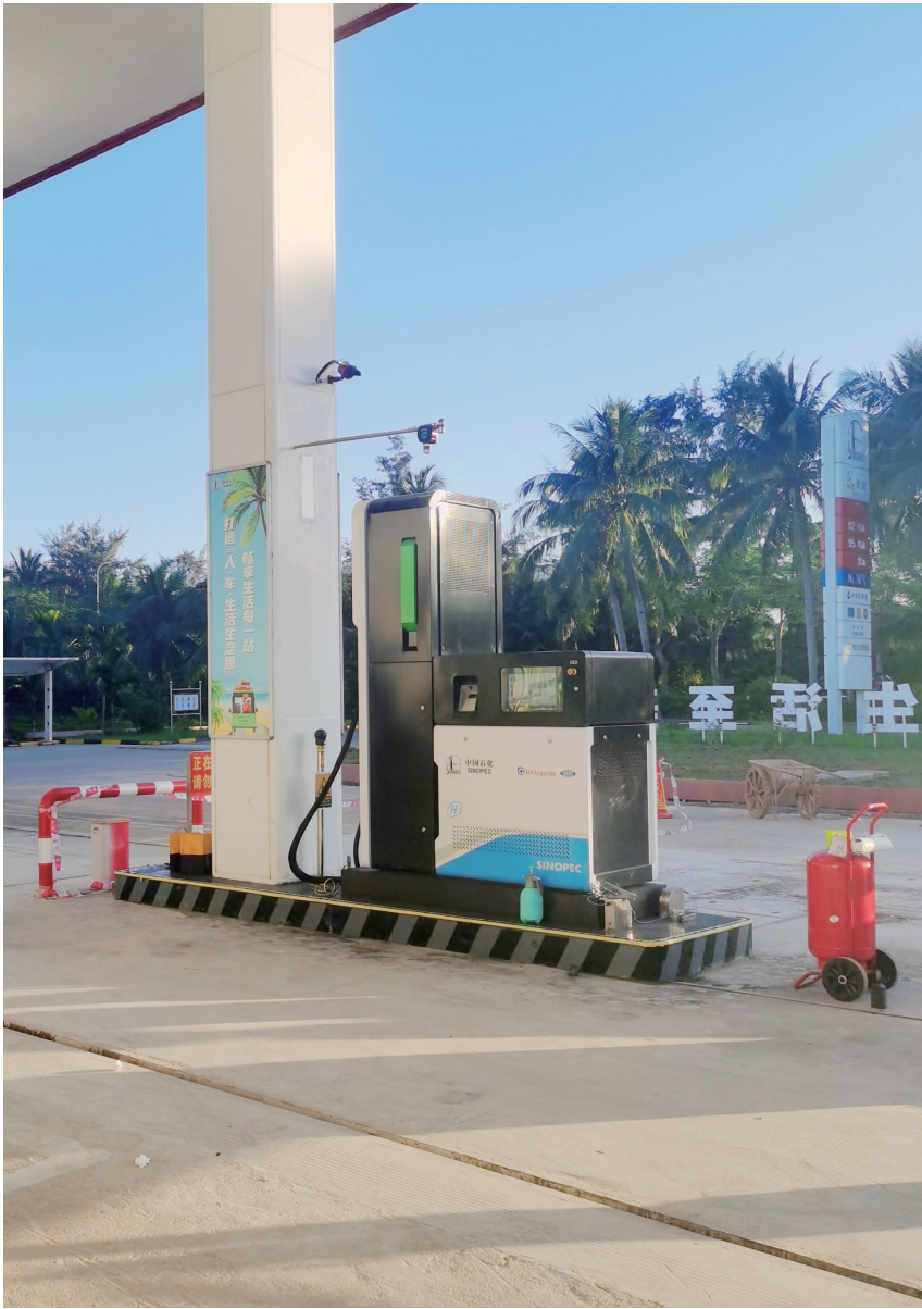
厚普装备首台双枪异压双计量加氢机在中石化银丰加氢站成功应用
