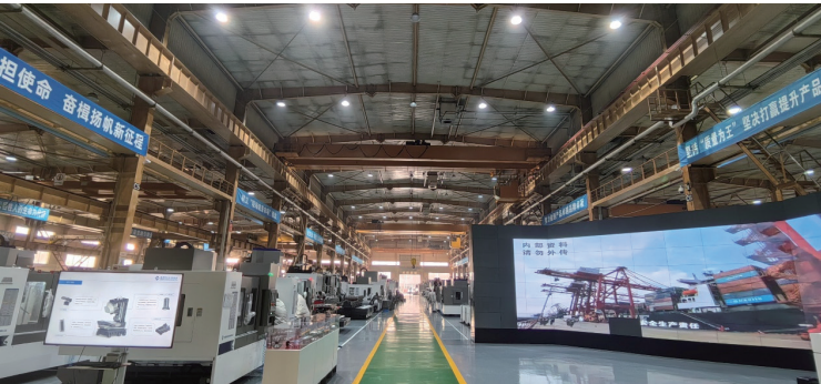
绿色照明改造 -led 替代
