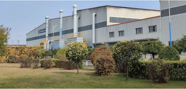
⇨ 除尘器升级改造
