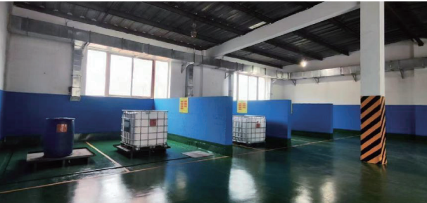
⇨ 危废库照片（升级改造后）
