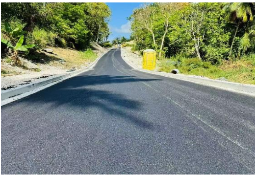
巴巴多斯苏格兰地区道路修复项目
