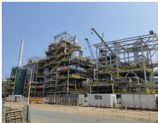
山东裕龙产业园危废焚烧项目
