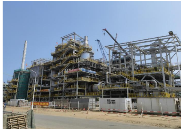
山东裕龙产业园危废焚烧项目
