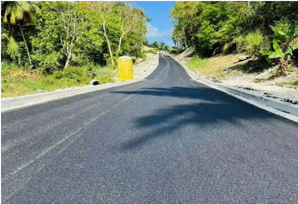
巴巴多斯苏格兰地区道路修复项目
