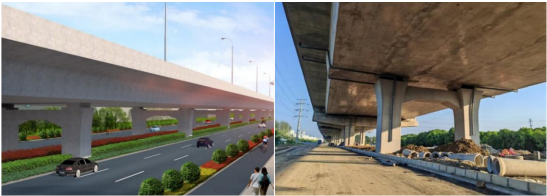
联长 865m 的超长连续高架桥
