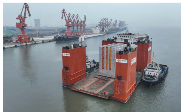
钦州港大榄坪作业区 4 号、5 号泊位工程首件沉箱安装
