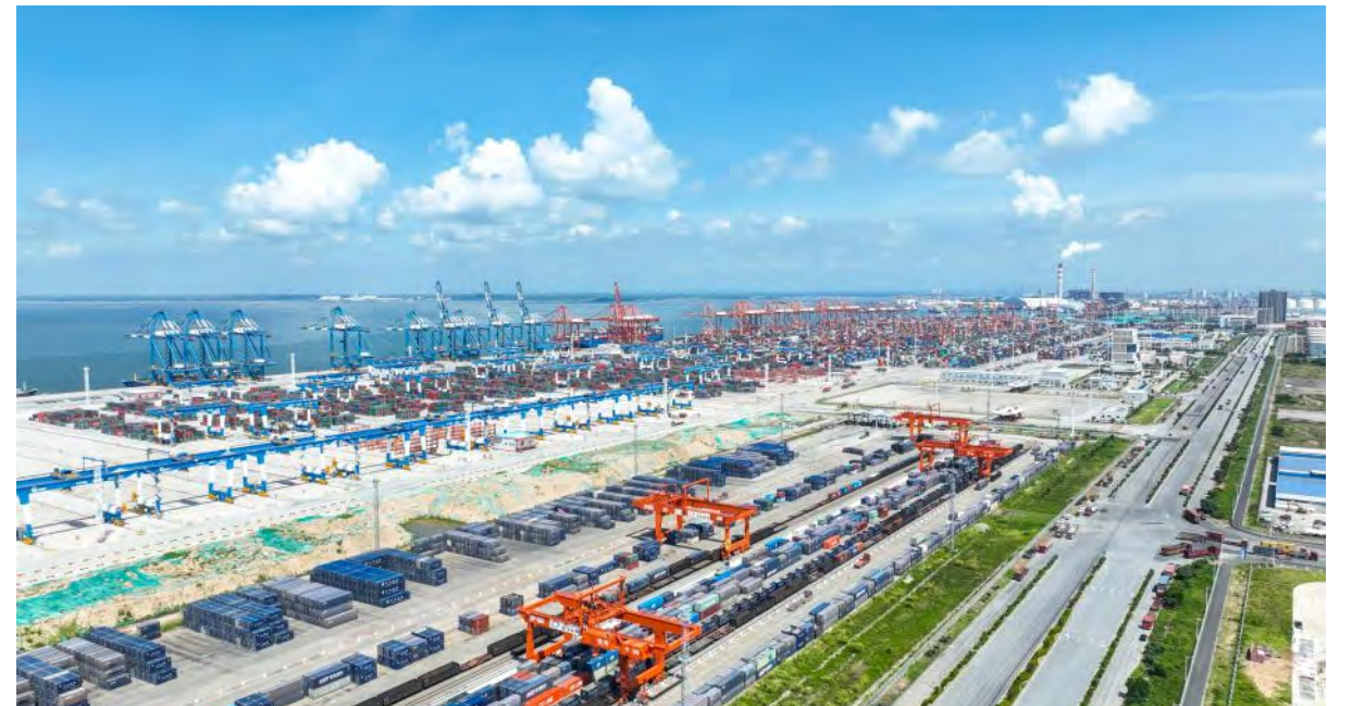
北部湾港钦州海铁联运一体化
