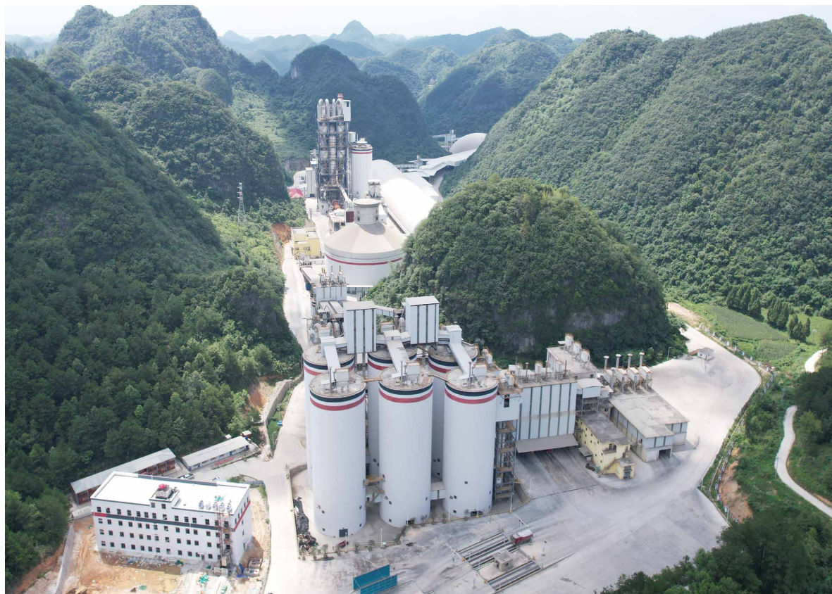
◎贵州独山日产4500吨新型干法水泥熟料生产线
