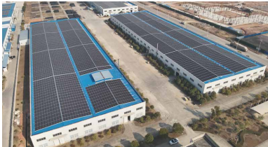
◎安徽汇久1200kWp光伏发电项目
