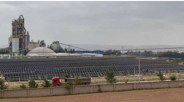
◎宁夏上峰4MWp分布式光伏项目
