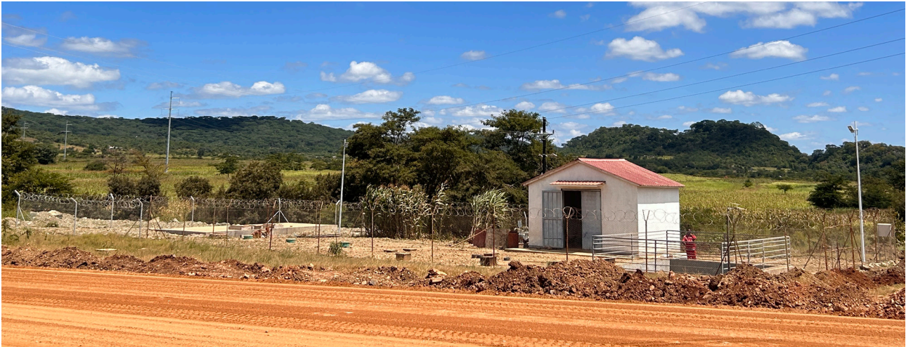
Bikita 废水处理设施
