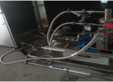
▲超纯水浓水管路改造
