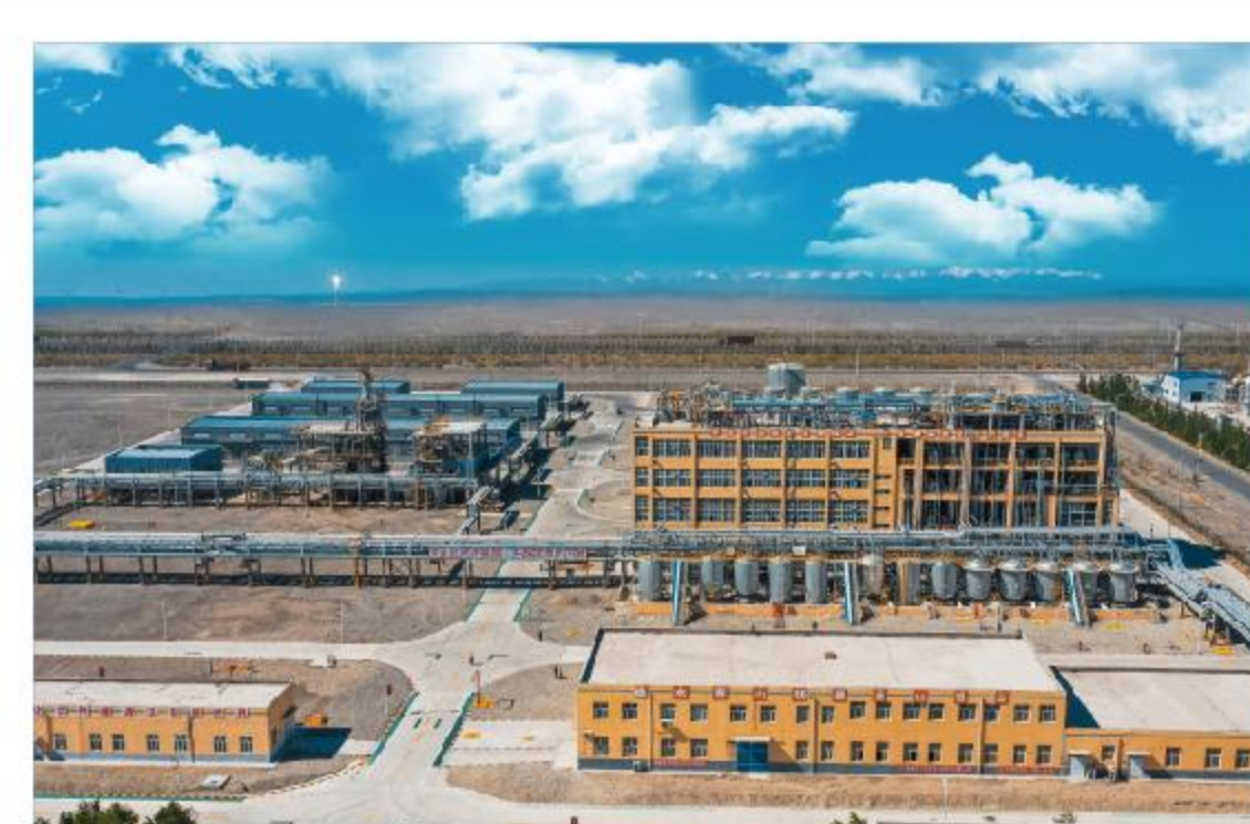
广汇硫化工公司新建3000吨/年二甲基亚砷项目一次开车成功
