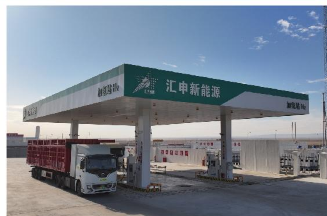
广汇能源绿电制氢及氢能一体化示范项目实现5MW风机绿电网网成功
