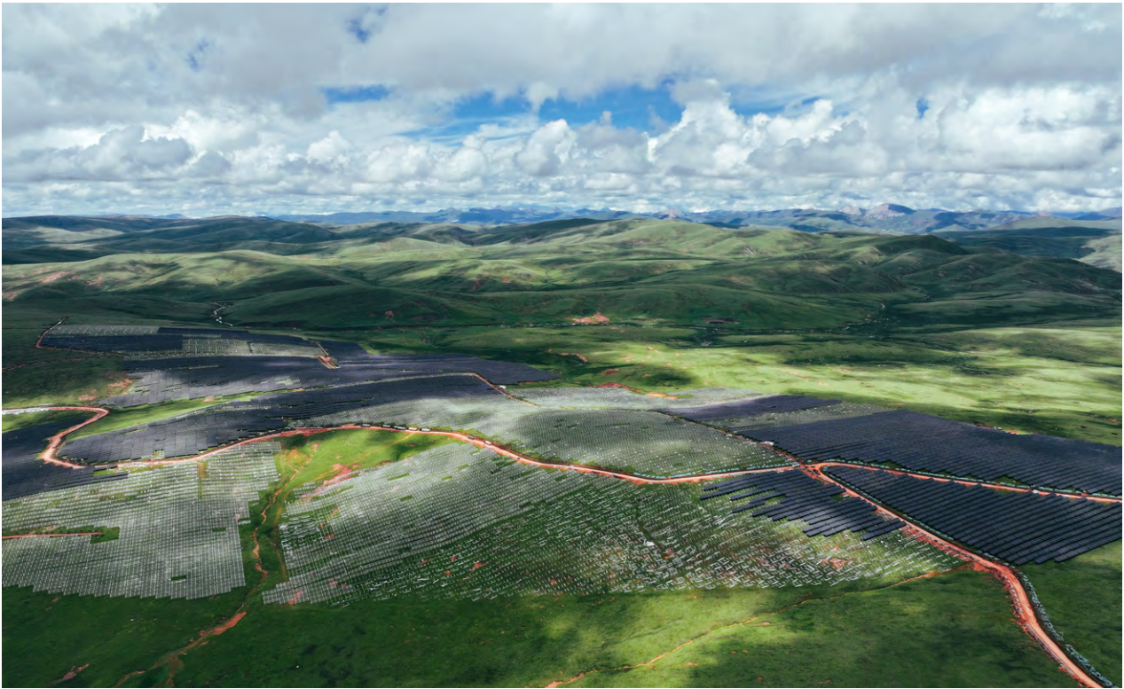
西藏华电昌都芒康昂多1800MW光伏发电项目
