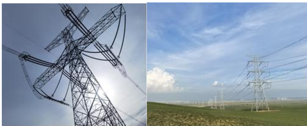
图：宁夏-湖南±800kV 特高压直流输电工程&张北-胜利 1000 千伏特高压交流工程线路工程
