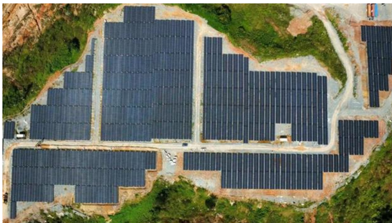
图：圭亚那微电网项目
