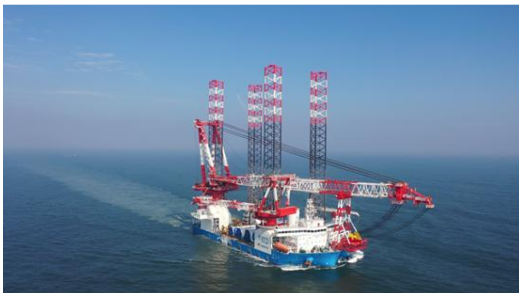
图：中天 31 在阳江海域青州六项目通过自运自吊安装工艺将可作业窗口期从 8 天提升至 20 天
