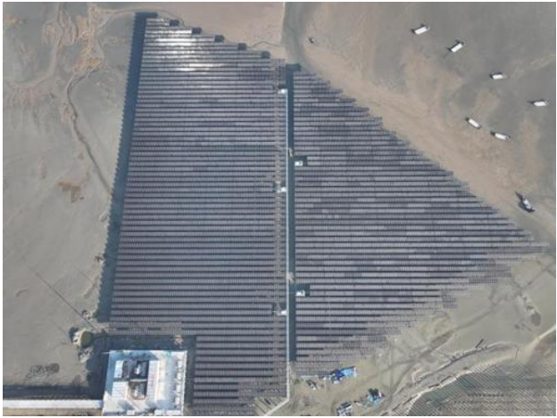
图：国华光氢储一体化 400MW 光伏项目
