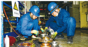
上都发电公司机化检修人员维修更换6号机组凝结水泵机封
