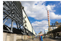
上都发电公司一期煤场安装管桁架，有效抑制扬尘
