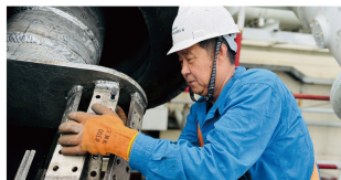
丰电能源公司利用6号机组大修对主变低电压侧软联进行拆除
