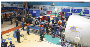
乌海发电厂检修人员进行5号机组A级检修发电机电穿转子工作
