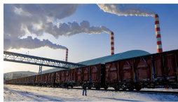
上都发电公司严把输煤接卸关口，强化入厂煤巡检力度，加强清冻煤管理
