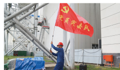
和林发电公司举办氨区重大危险源综合治理改造项目开工仪式
