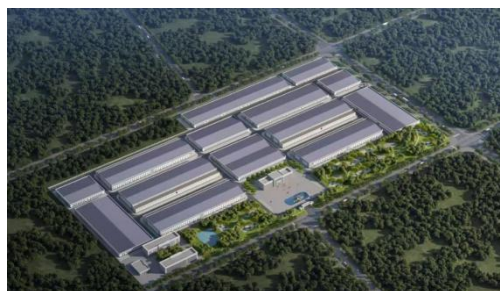
新疆信达铝电解电容器用中高压化成箔项目 EPC 总承包项目
