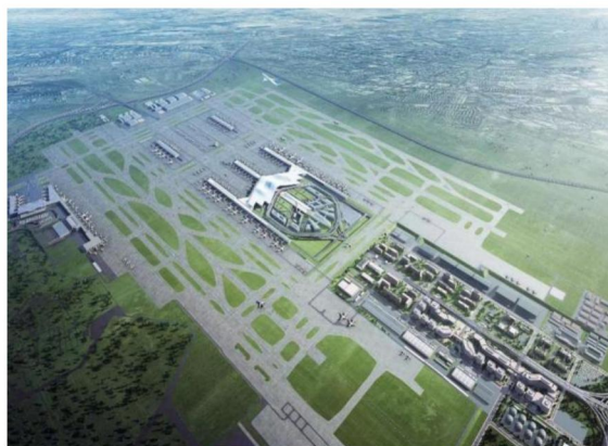
乌鲁木齐机场 OMC 项目
