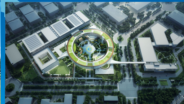
拓荆创益（沈阳） 沈阳二厂（建设中）
