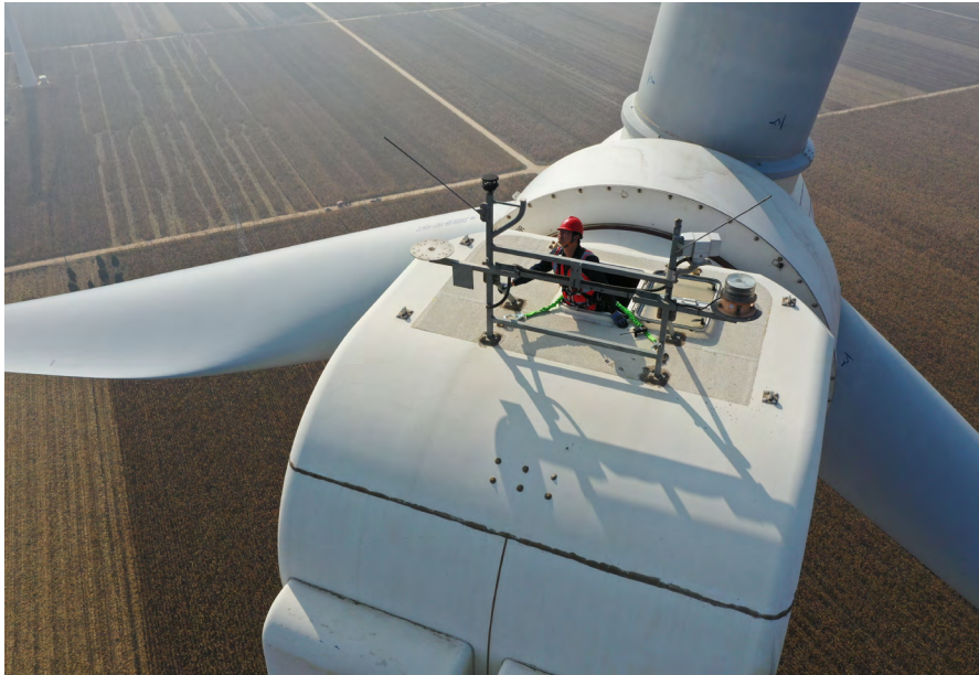
风电场出舱巡检
