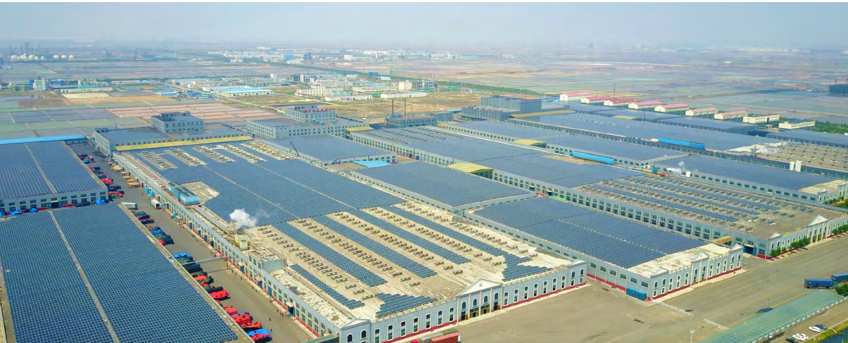
山东昊华屋顶光伏项目
