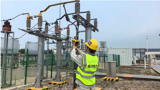
对风电场刀闸触头开展测温工作
