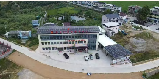
海会村光伏发电项目
