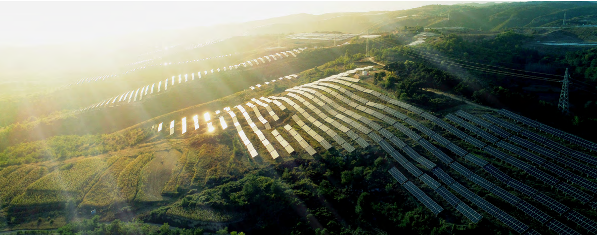
山西孟县光伏项目
