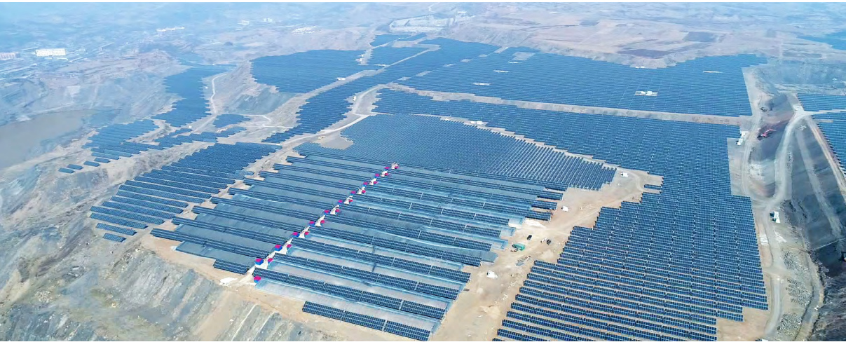
山西平定光伏项目
