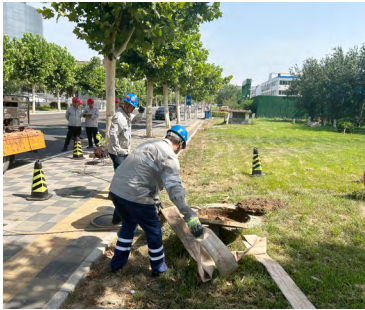
模拟演练抽取管井内积水
