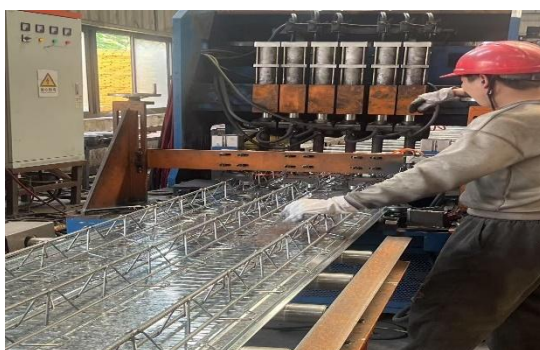
镀锌板桁架筋焊接
