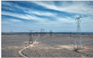
“疆电外送”直流第三条通道 哈密-重庆±800KV特高压直流输电工程
