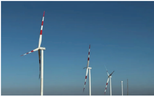
埃及最大的风电项目 埃及GOS II 国际风电场项目
