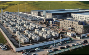
国内单体规模最大的组串式储能电站 河北衡水200MW/800MWH 独立储能电站
