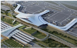
西宁曹家堡国际机场 工商业储能项目
