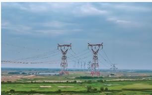
武汉-南昌1000KV特高压交流输电工程
