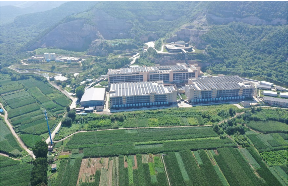
楼房猪场光伏建设
