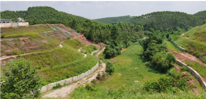
大塘镇项目挡墙边坡支护工程
