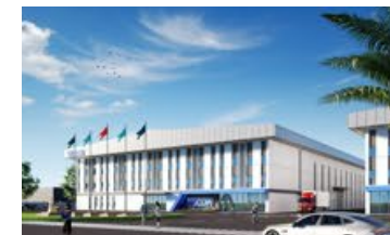
泰国 (建设中) 建筑面积: 45,000m 2
