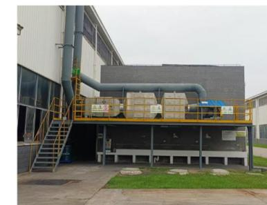
**节能技改：退火废气处理**
