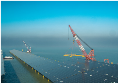
11月13日,中国电建勘察设计的中国首个百万千瓦级海上光伏项目——山东垦利100万千瓦海上光伏项目首批光伏发电单元成功并网。
