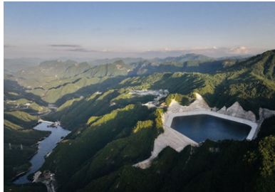
11月19日,由中国电建设计、承建的我国西北地区首个开工建设的抽水蓄能电站工程——陕西镇安抽水蓄能电站举行投产发电仪式。
