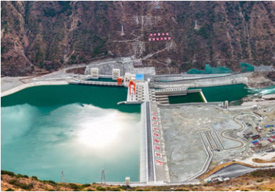
12月29日,中国电建设计施工的国内洞径最大引水式电站——四川大渡河硬梁包水电站举行首台机组发电仪式。
