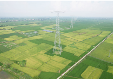
10月25日,中国电建参建的武汉至南昌1000千伏特高压输电线路项目实现投产送电,标志着我国华中地区“日”字形特高压交流环网正式形成。
