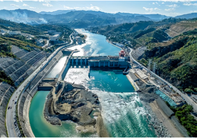
12月31日,由中国电建承建的全国首个在城市中心建设的大型水电站——银江水电站首台机组正式投产发电。
