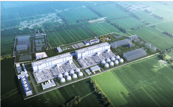
华能金坛盐穴压缩空气储能发电二期项目
