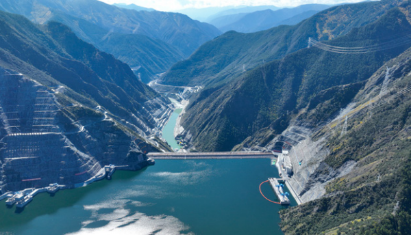
世界已建最高土石坝——雅砻江两河口水电站蓄至正常蓄水位
