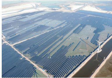
12月12日,由中国电建主力承建的国务院批复的首个立体确权光伏海项目——华能滨州新能源85万千瓦光伏发电项目实现首批60万千瓦并网发电。
