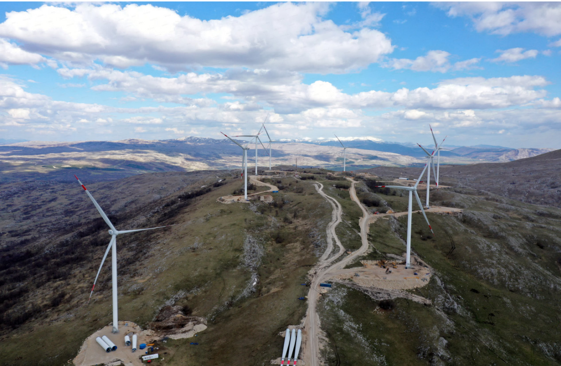
波黑伊沃维克 84 兆瓦风电项目
