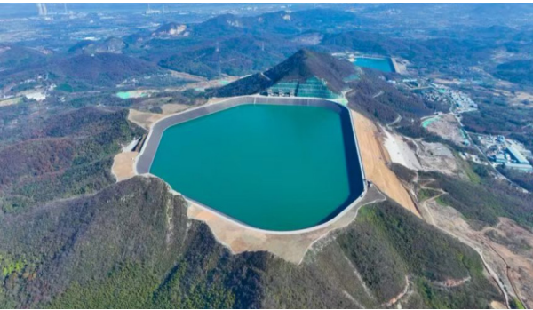
世界最大库盆填筑工程——江苏句容抽水蓄能电站上水库正式蓄水
