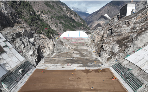
双江口水电站大坝填筑全景
