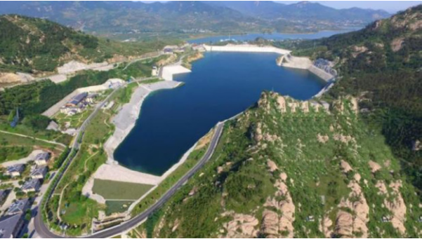
山东沂蒙抽水蓄能电站
