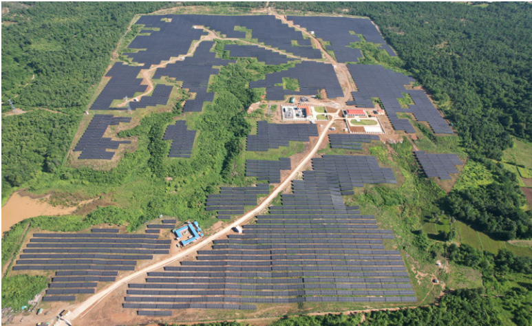
缅甸中部光伏项目群
