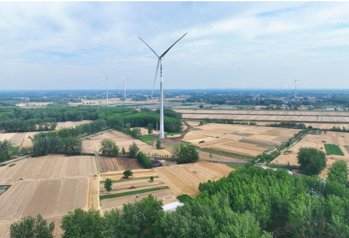
安徽阜南南部风光储基地阜南 300 兆瓦风电项目
