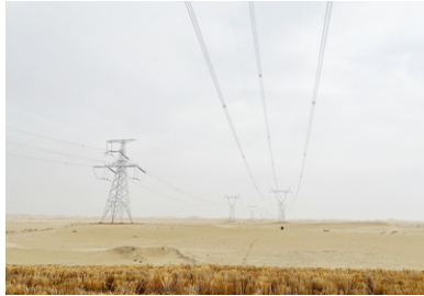
12月14日,中国电建参建的巴州—铁干里克—若羌750千伏输电工程正式投产送电,标志着我国“十四五”期间单体投资规模最大的750千伏输电工程建成投运。
