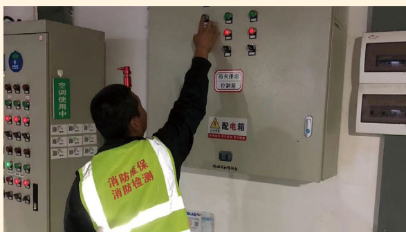
配电柜安全检查
