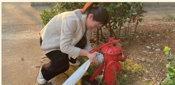
消防设备隐患排查
