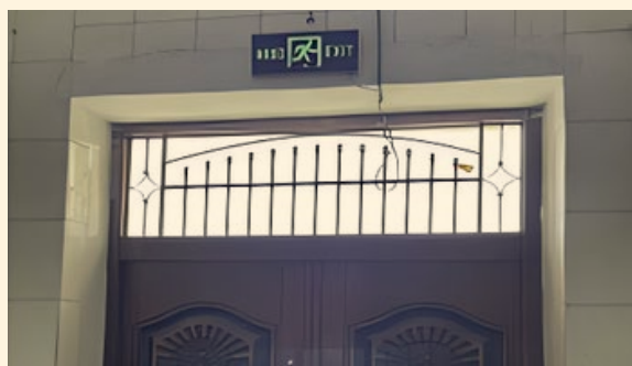
安全指示灯牌整改
