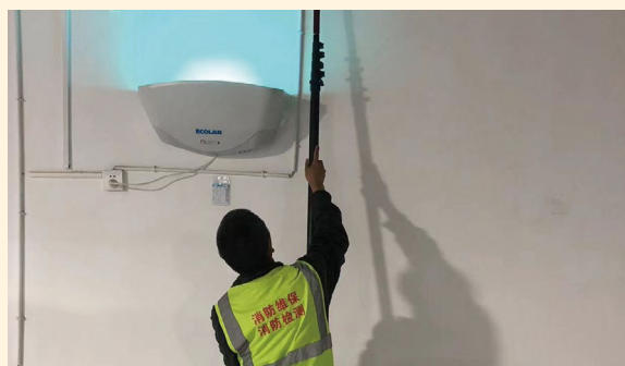
应急照明设备检查
