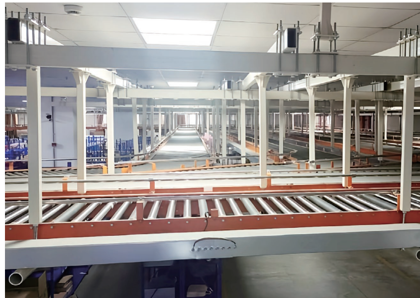
奉金路智能仓储建设情况
