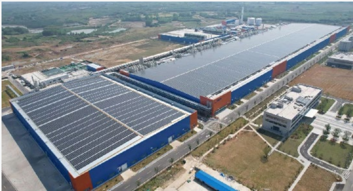
亿晶滁州基地 19.8MW BIPV 项目地实拍图
