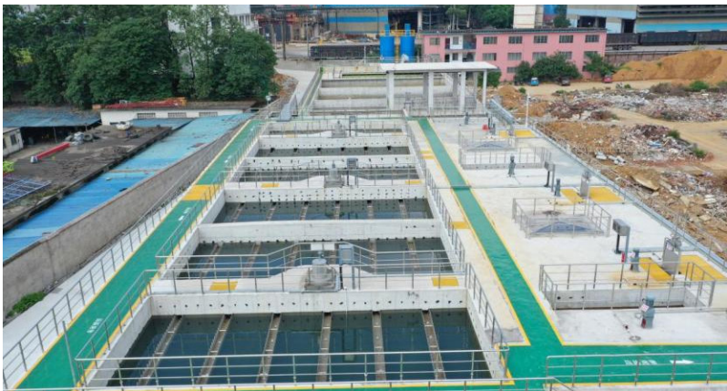
3# 废水处理站二期工程
