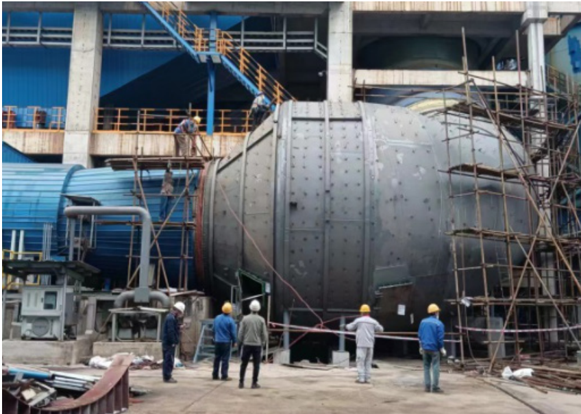
增压风机出口安装矩阵式排风消音器
