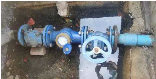
洪湾中心渔港码头水表(改造前)
