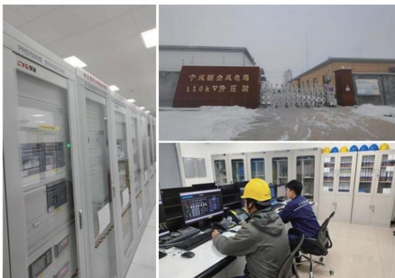
每台机组均采用一机一变单元接线方式，将电压提升至35kV，并通过四条35kV的集电线路接入110kV升压站的35kV母线。年理论发电量预计可达24996.6万kWh，理论发电小时数为2500小时，容量系数为0.2854，相当于每年减少二氧化碳排放约19.15万吨。
