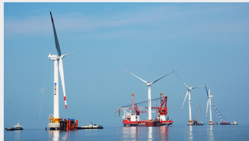
三峡福建兴化湾海上风电样机试验风场
