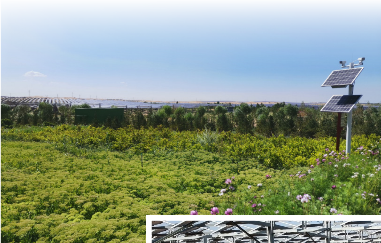
内蒙古库布其光伏治沙项目
