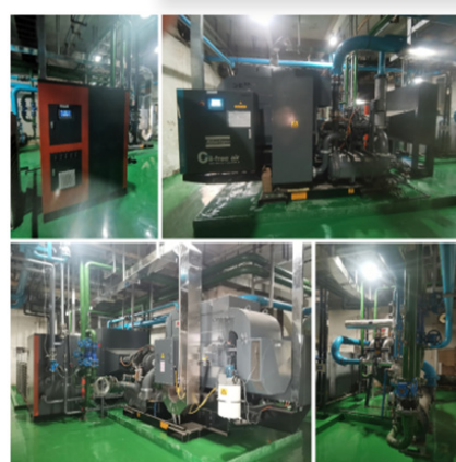
安装智能空压站
